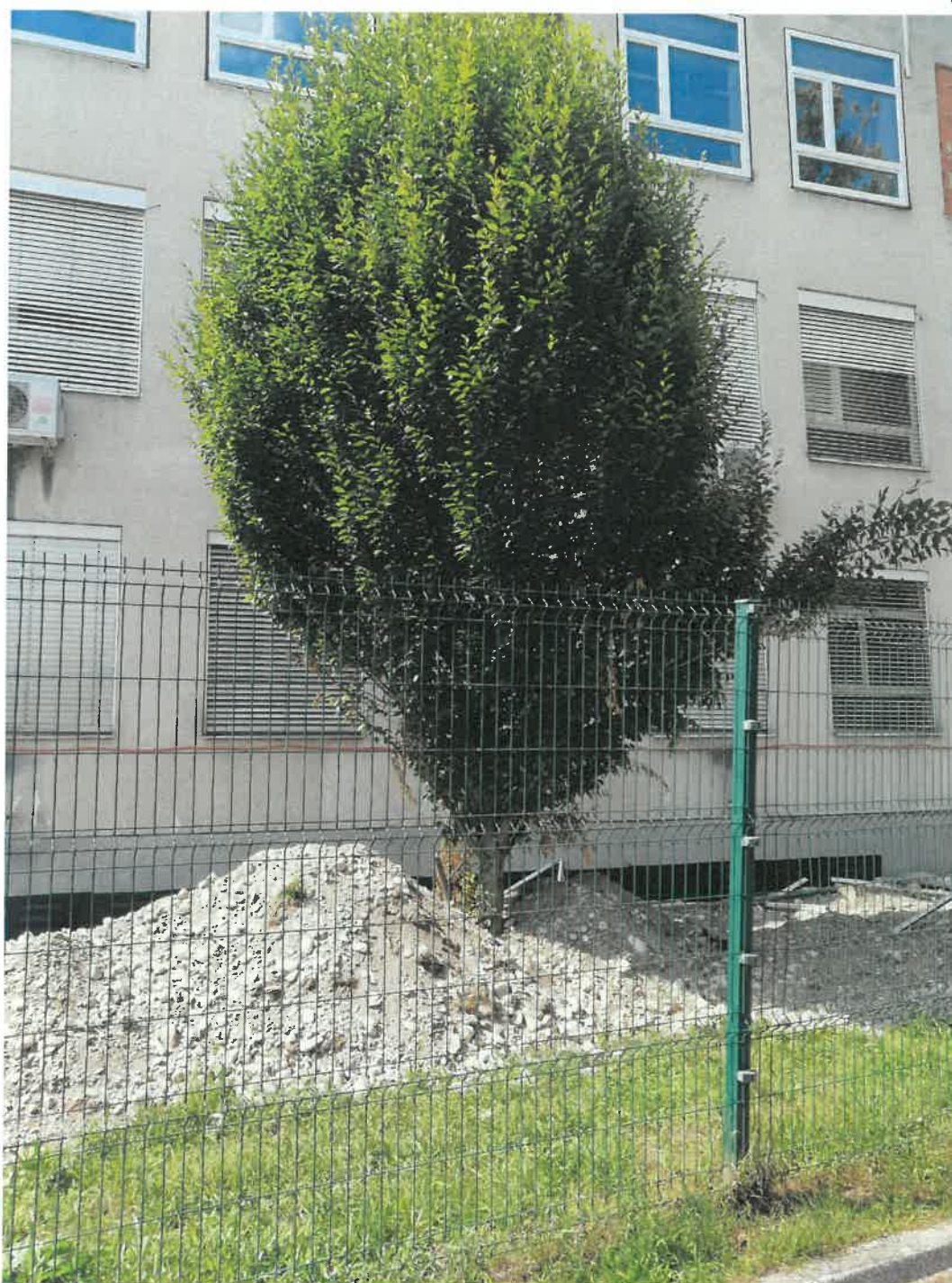
Fotografija 7: Isto drevo kot na fotografiji 6 fotografirano med gradbenim delom. Veje drevesa so poškodovane, izkopani material je naložen pod drevo tik ob deblu. Zaradi tega lahko drevo propade in se posuši. Drevo je treba takoj zavarovati in odstraniti ves izkopan material izpod drevesa.
